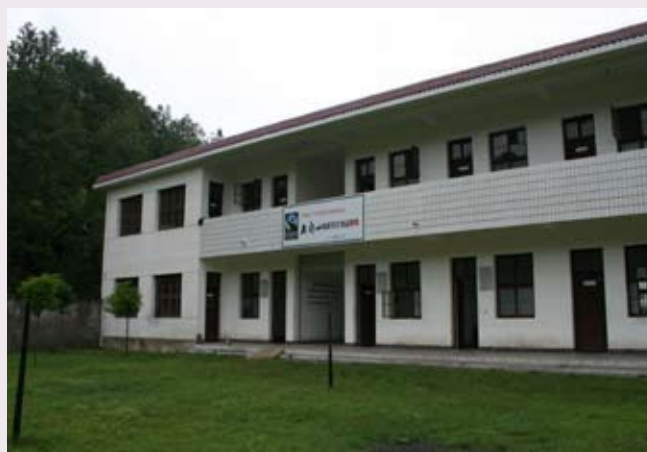
Der Erweiterungsbau der Mittelschule
