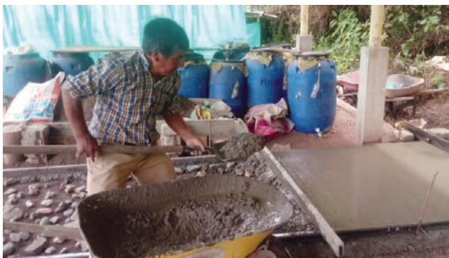
Bau einer Bio-Düngemittel-Anlage beim Handelspartner ASPROALMAGUER
